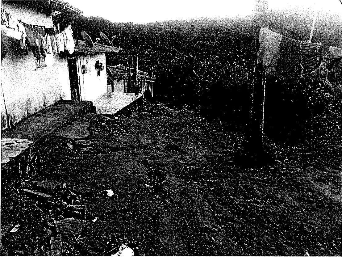
Rua 03 Adjacente a Rua da Marinês – Final da Rua (Long 494466.5300; Lat 9511355.4700)
