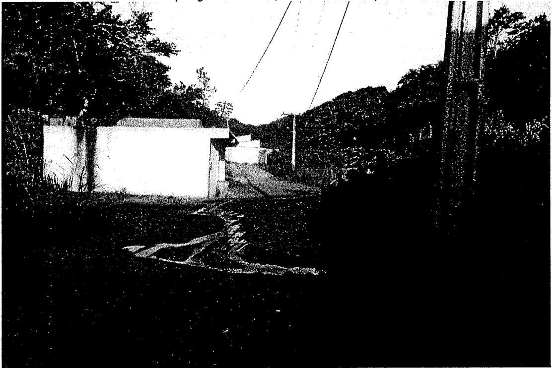
Rua de Acesso ao Camará – Início da Rua (Long 495129.4900; Lat 9511433.1100)
